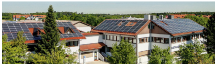
Firmenzentrale Oberhaching bei München
