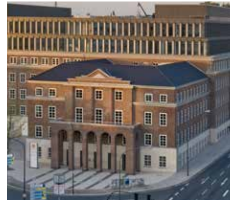
Glückaufhaus – „Die Unternehmenszentrale von ifm in Essen“
