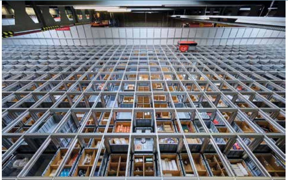
Auf einer Grundfläche von nur 400 Quadratmetern bietet die AutoStore-Lösung von Element Logic mit 11.650 Behältern rund 25.000 Lagerplätze.
