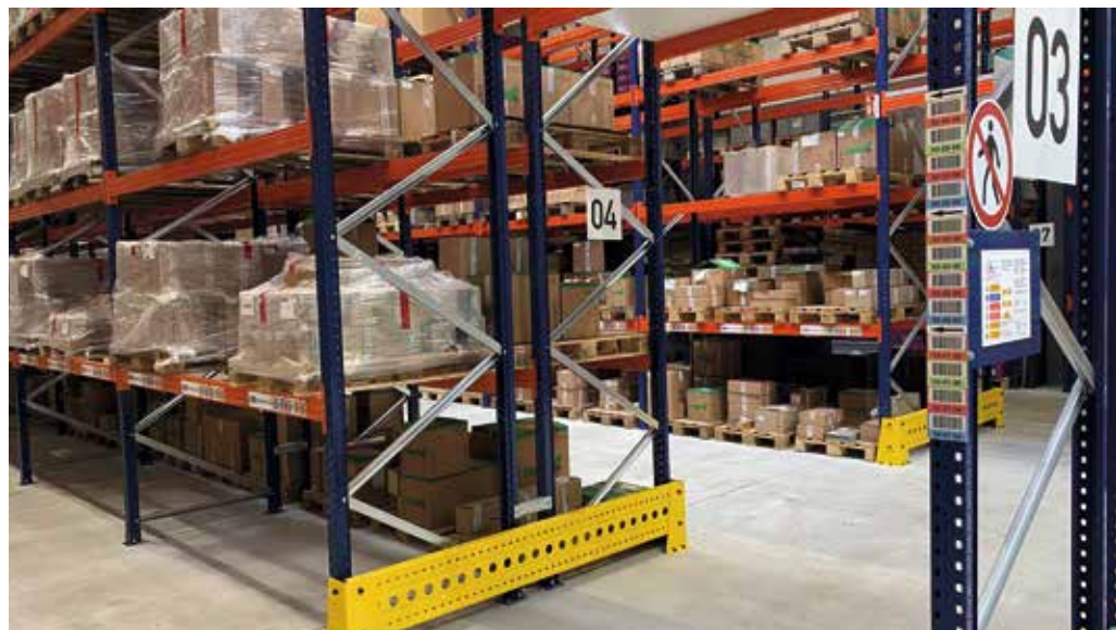
Im Vorfeld der Produktion und Montage hatten sich der Vertriebsleiter von ONK und der Teamleiter Materialwirtschaft bei Lohmann über die Bedürfnisse von Lohmann und daran angepasste Kennzeichnungslösungen intensiv ausgetauscht.
