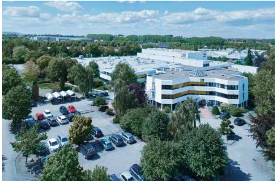
Rose hat sich für ein Retrofit mit Erweiterung entschieden. viastore liefert dafür Hardware, Software, Know-how - und die Umsetzung.
