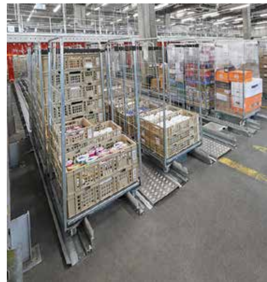
Modernisierung eines vormals manuellen Warenausgangsbereichs durch automatisierte Bereitstellung der Paletten und Rollcontainer.
