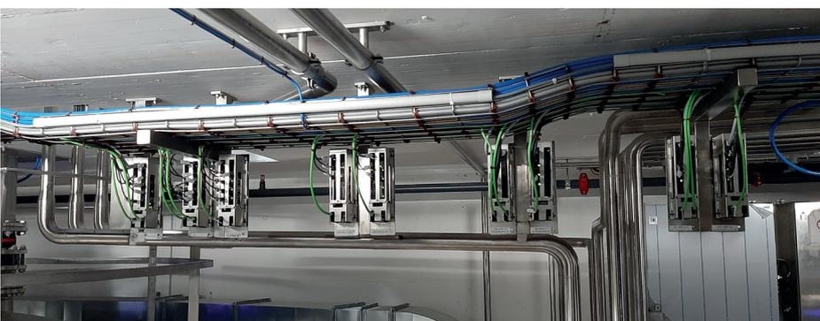
Die TBEN-I/O-Blockmodule sind platzsparend unter den Kabeltrassen in ATEX-Schutzgehäusen installiert
